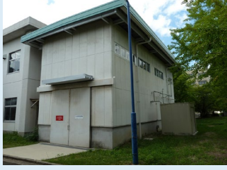
水素実験棟 国内の大学では唯一の液体水素専用実験棟
