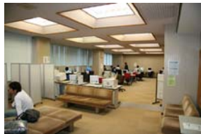
【写真2】同2階情報検索コーナーの床をOAフロアに改修し、利用者PCを増設
