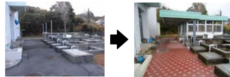
【写真11】屋外実習施設の整備
