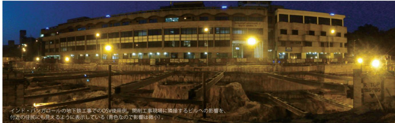
インド・バンガロールの地下鉄工事でのOSV使用例。開削工事現場に隣接するビルへの影響を、付近の住民にも見えるように表示している（青色なので影響は微小）。
