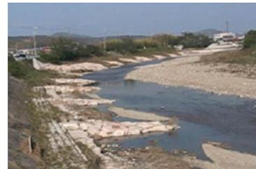
写真3 明石川の水制群
