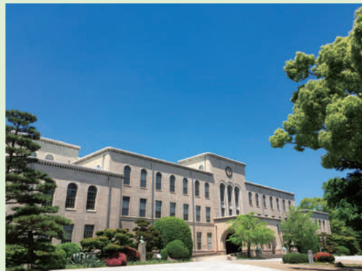
撮影場所：六甲台第一キャンパス (正門階段から六甲台本館を撮影)
