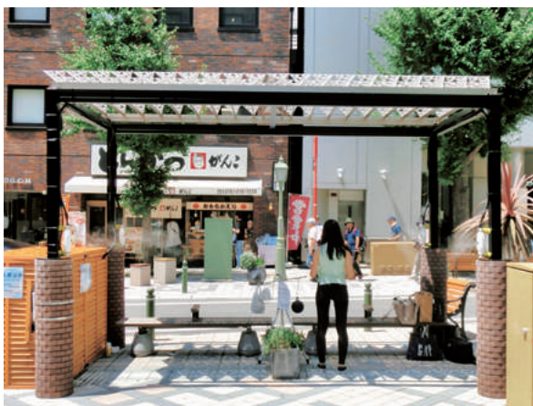
三宮に導入されたクールスポットと測定の様子 フラクタル日除け(上部)とミスト(4支柱)
