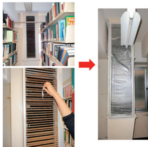
写真1 換気口の閉鎖(換気扇はOFFであるが、外気の入りが確認されたため、ビニールシートで閉鎖)
