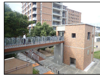
段差解消の取組 (エレベーター棟整備)
